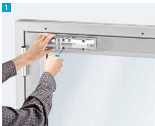
2 Anschrauben der Grundplatte des Sicherheits-Türschließers
