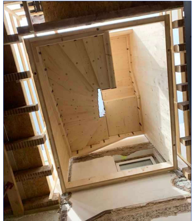
Bild oben: Modul wird in Bestand herabgesenkt
