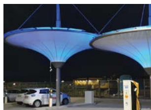
Entega Energietankstelle, Darmstadt
