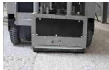
Fräsen von Beton und Estrich
