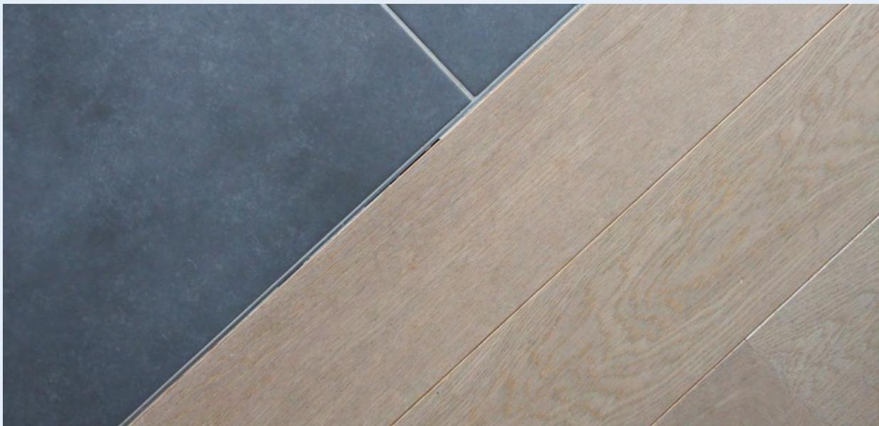
Zu klein dimensionierte Bewegungsfugen (aus architektonischer Sicht gewollt) führt zum Aufreißen des Dichtstoffes, da dieser an seine Leistungsgrenzen kommt
