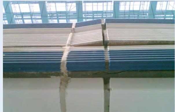
Schaden wegen zu klein dimensionierter Bewegungsfugen in einem Schwimmbadbeckenkopf
