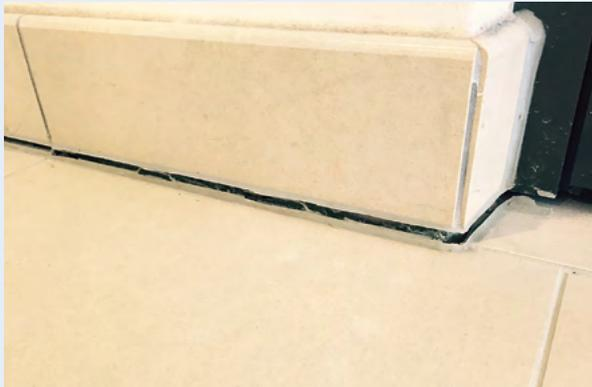
Überdehnung des Dichtstoffes mit Rissbildung im Bereich des Sockel-Wand-Anschlusses
