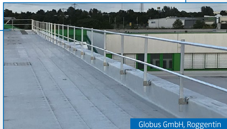
Passt unter handelsübliche Attika-Abdeckungen
