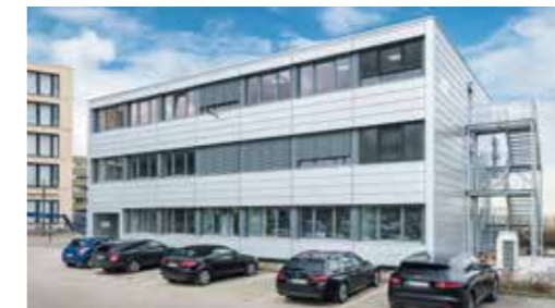
Kornwestheim , 3-geschossiges Bürogebäude, BGF 830 m 2
