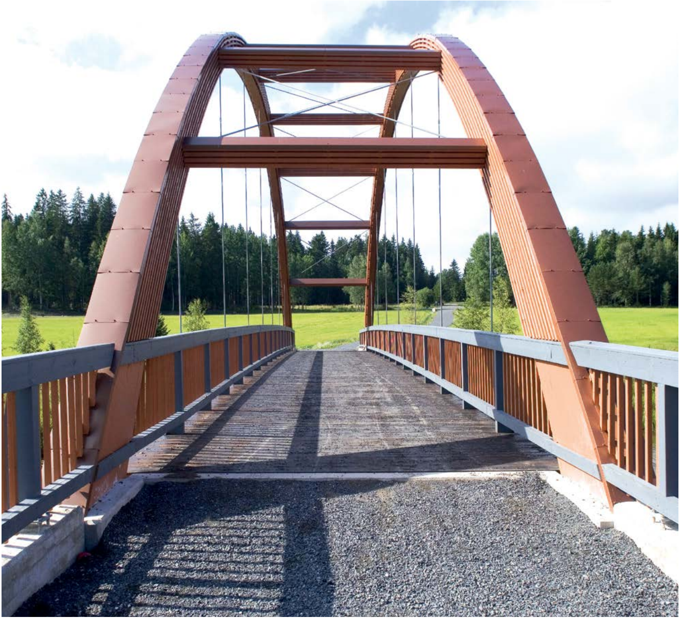
Kurjenmäen silta, Ypäjä
