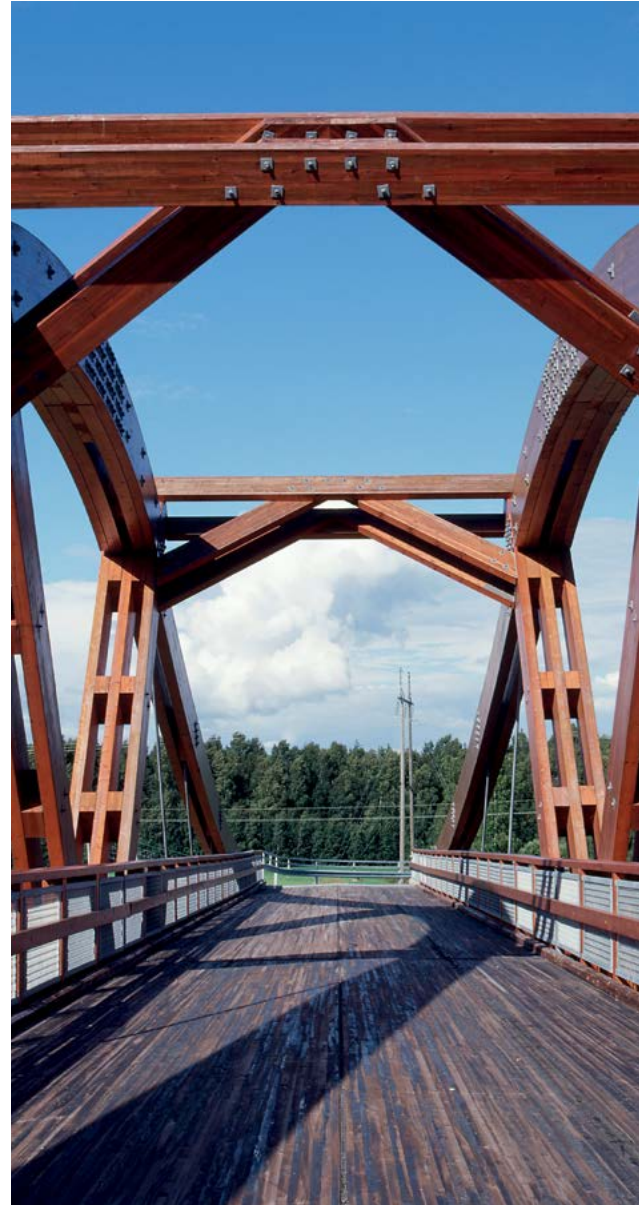
Nahkia Bridge, Toijala
