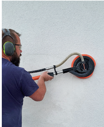
Putz abräumen mit PKD Scheibe
