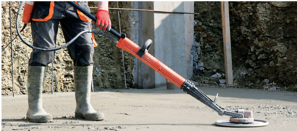
Egalisieren von Betonflächen
