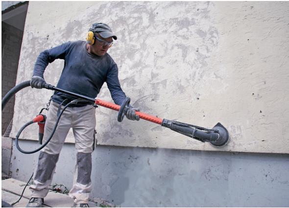
Alte Farbe und Putz entfernen
