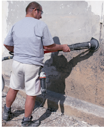
Bitumen schleifen mit dem PKD-Schleifteller
