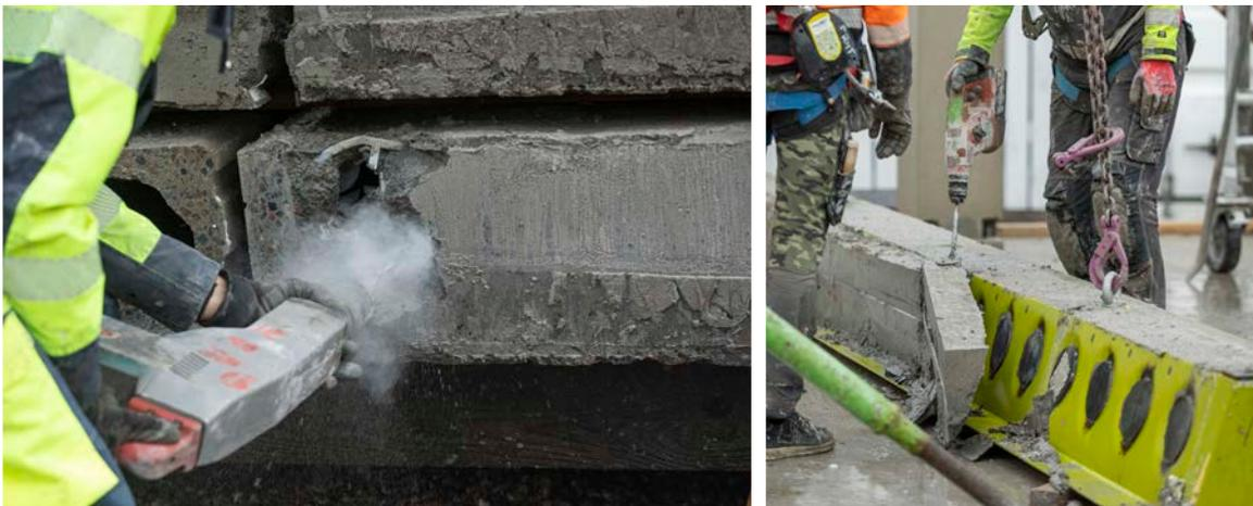
Abbildung 22. Säubern der Elemente ( Decke oben und Träger unten) in Vorbereitung auf die Wiederverwendung
