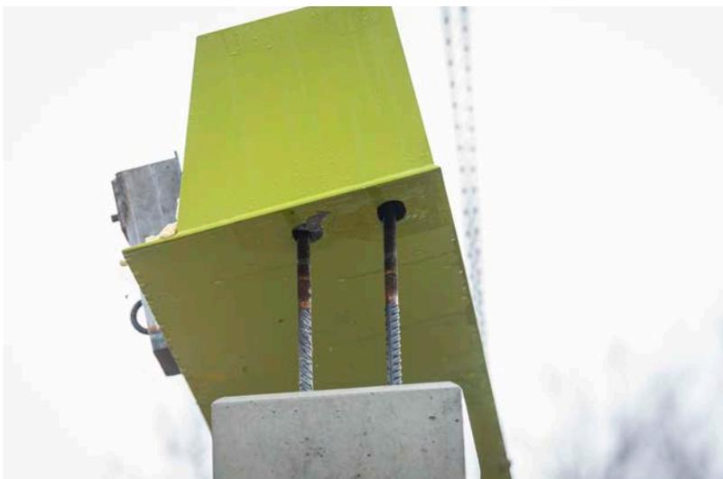
Abbildung 15. Von der Stütze abgehobener DELTABEAM®
