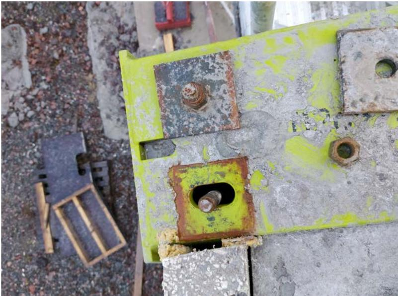
Abbildung 13. Von den Bolzen abgeschraubte Muttern
