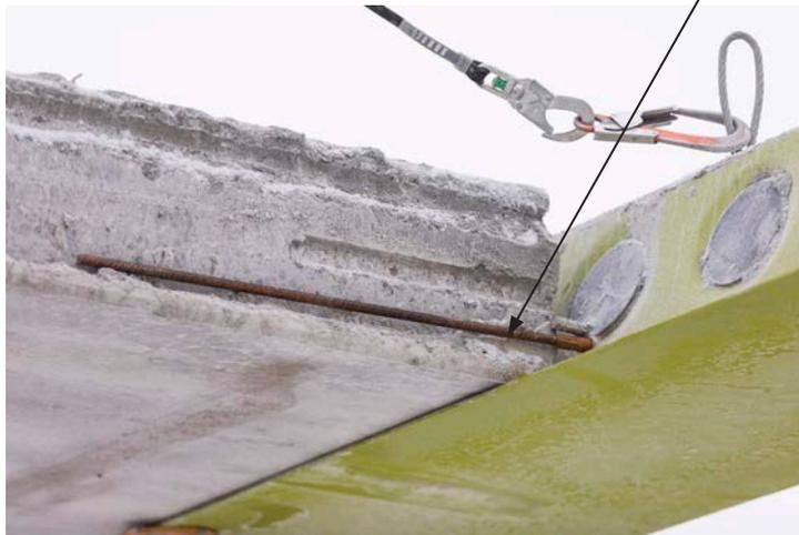
Abbildung 24. Teil B der MODIX® Schraubmuffe fest eingeschraubt in Teil A
