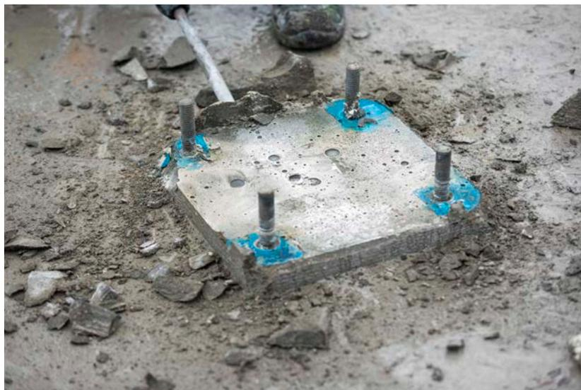
*Abbildung 5. Entfernen des ausgehärteten Mörtelbetts*
