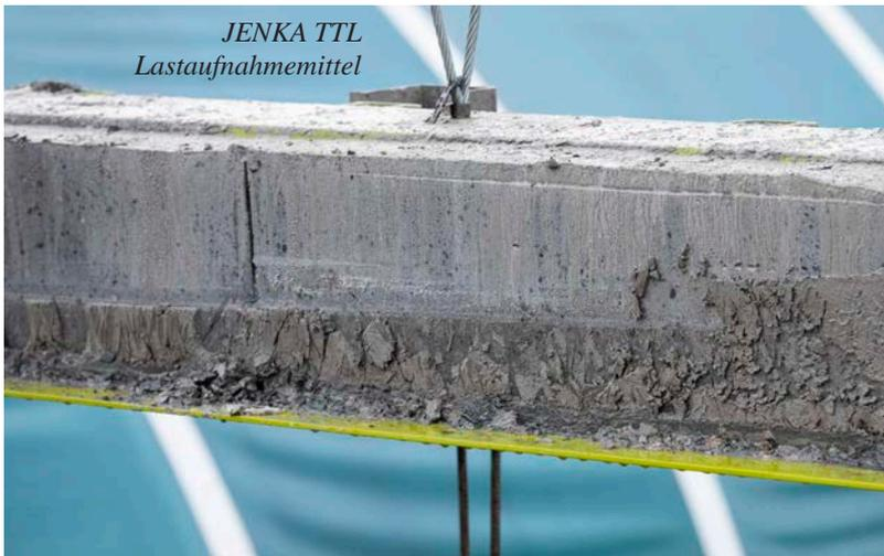
Abbildung 14. In den DELTABEAM® eingeschraubtes JENKA Lastaufnahmemittel, bereit zum Heben
