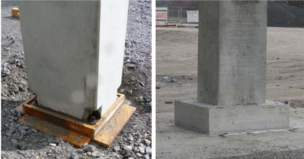
*Abbildung 2.* Schalung bereit für den Verguss (links), fertige Verbindung nach dem Aushärten des Vergussmörtels (rechts)
