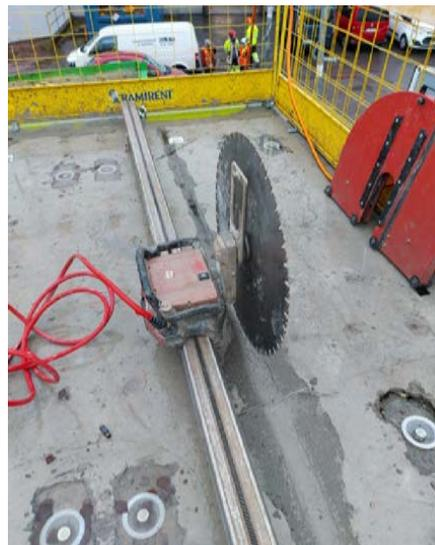
Abbildung 21. Trennen der Längsfugen zwischen den Hohldielen mit einer Diamantsäge
