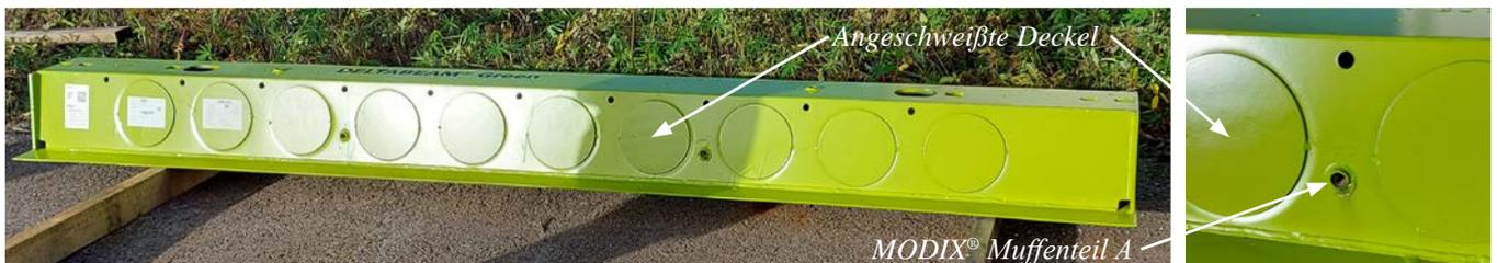
Abbildung 16. Träger mit Schweißdeckeln zum Verschließen der Stegöffnungen und MODIX® Muffenteil A
