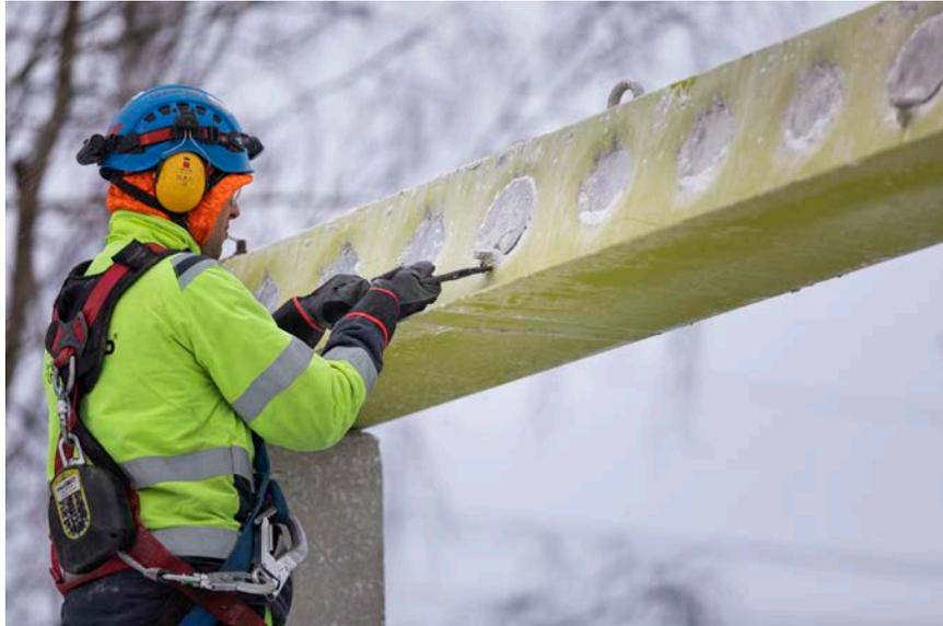
Abbildung 23. Abziehen des Stopfen von MODIX® Muffenteil A
