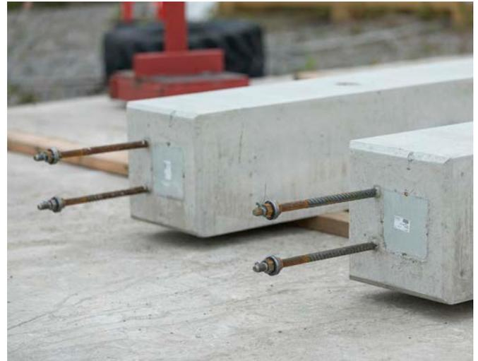
*Abbildung 8.* Schnittdetails der in die Stütze eingegossenen Ankerbolzen und Ankerplatte (links), Ankerbolzen und Ankerplatte in der Stütze (rechts)
