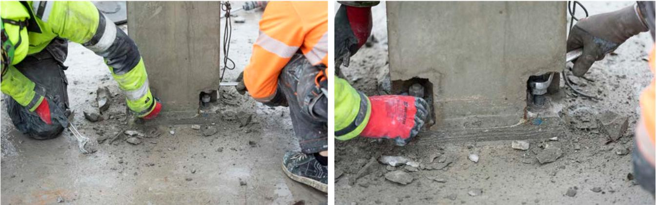
*Abbildung 4. Lösen und Entfernen der Muttern*
