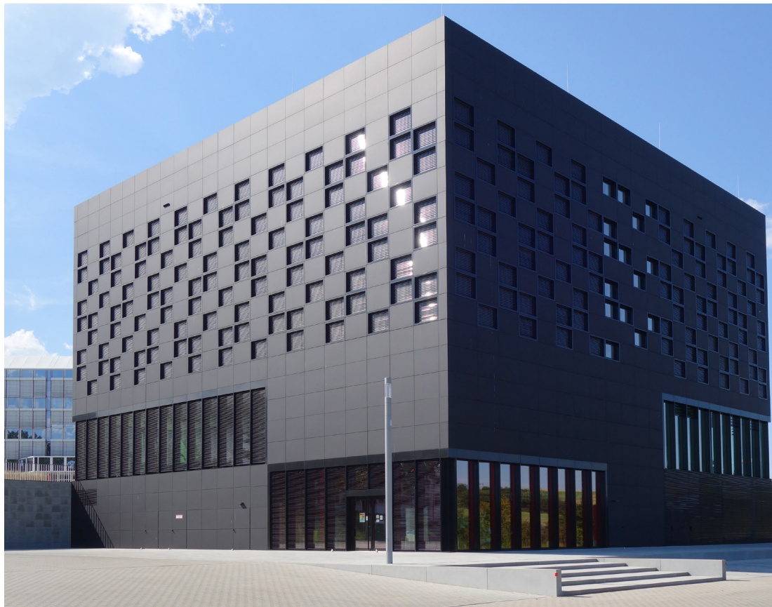
AVA-Lösung im Einsatz: Dess+Falk Projekt Stabilo-Markengebäude Cube, Heroldsberg Ingenieurgesellschaft Dess+Falk GmbH, Nürnberg
