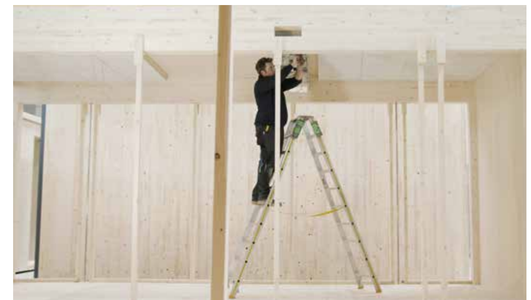
Installation der technischen Gebäudeausrüstung.
