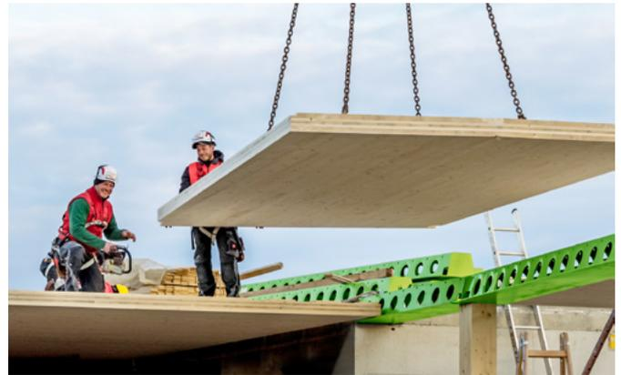
*Abbildung 1. Zur Verbesserung der Nachhaltigkeit wird die Slim-Floor-Konstruktionslösung von Peikko mit DELTABEAM® Green und CLT-Platten [14] realisiert.*
