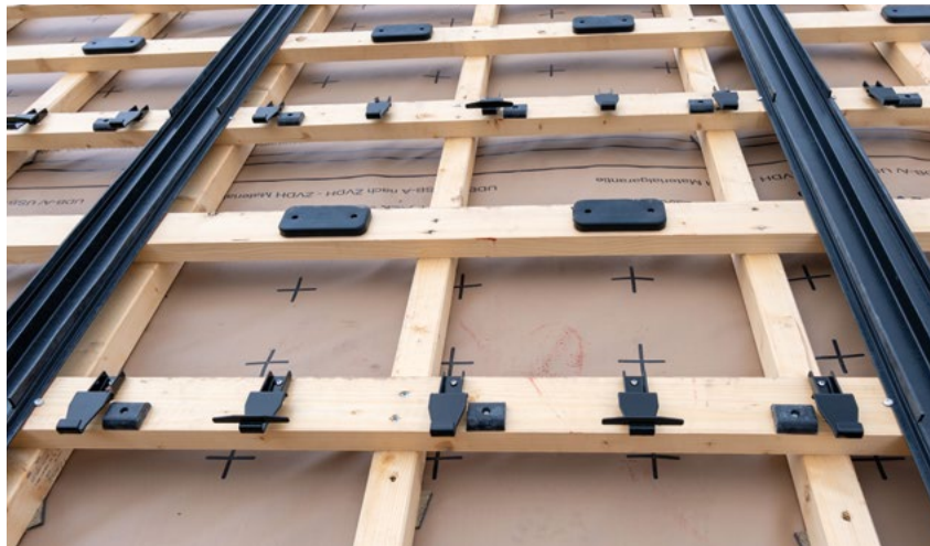
Unterkonstruktion der 3S Alpin+ Lösung: Fünf Alpin-Haken und in diesem Fall zwei Auflagegummis ermöglichen den Einsatz des TeraSlate Dachs auch in hochalpinen Regionen.
